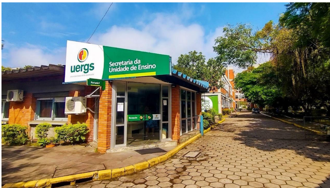
Figura 18: Secretaria da Unidade de Ensino Porto Alegre (Prédio 3), com placas novas.
